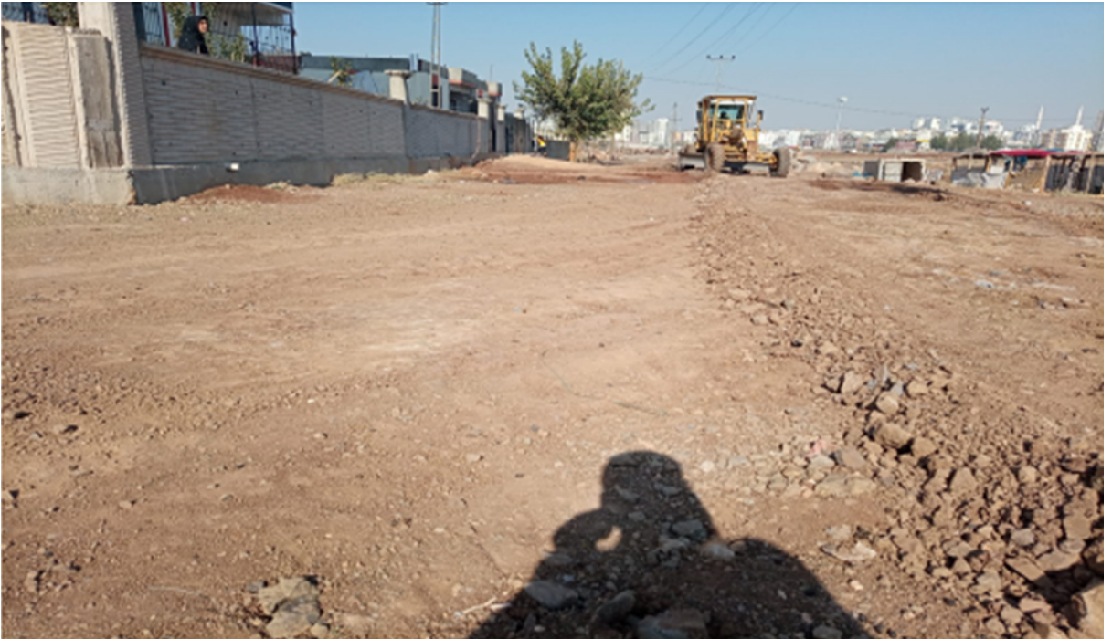
4-Bahçelievler stabilize yol çalışması
