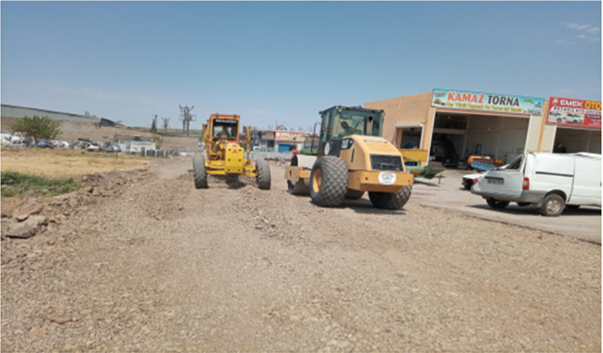
5-Sanayi sitesi stabilize yol çalışması.
